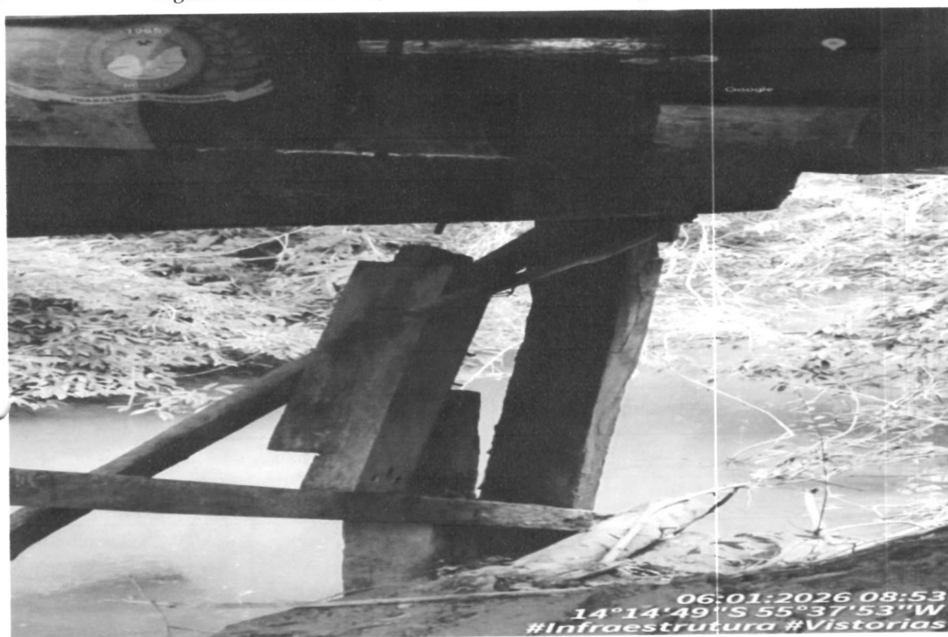
Figura 5 Estado crítico da ponte de madeira sinais de deterioração estrutural, comprometimento dos pilares e risco iminente de colapso, o que justifica tecnicamente sua substituição por bueiro.
